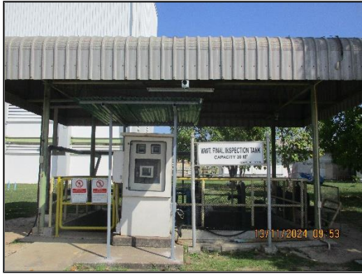
ภาพที่ 2.4 บ่อตรวจสอบคุณภาพน้ำ (Final Inspection Tank)
